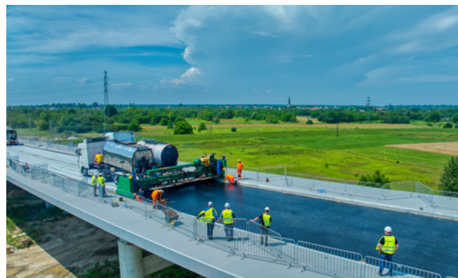
Budowa mostu na rzece San w Stalowej Woli, Generalny Wykonawca STRABAG.
